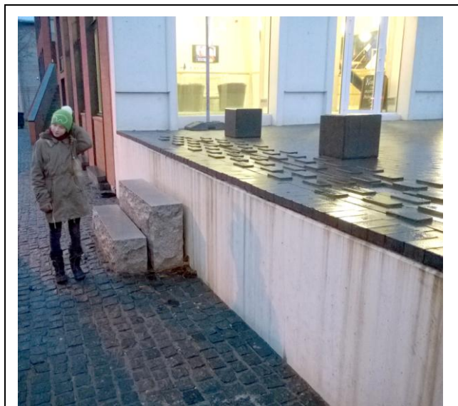
Tartu Ülikooli Narva kolledži juures ilma piirdeta terrassi serva näide (h=1m). Serv on markeeritud tõstetud sillutiskividega.
