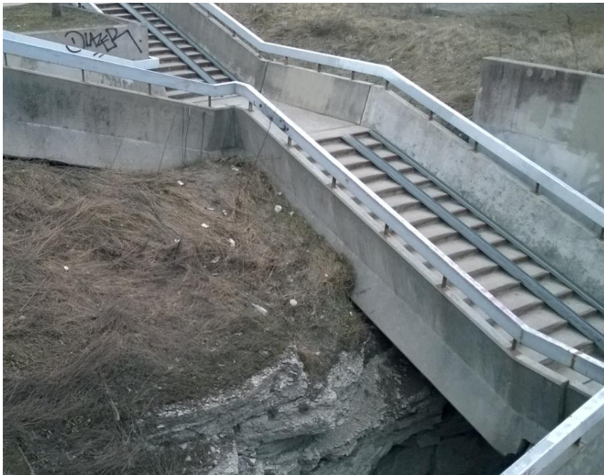
Laagna tee ääres asuv massiivne betoonist trepp. Trepp näeb väga massiivne ja pealetükkiv välja. Trepil on kahe poolne rattarenn.
